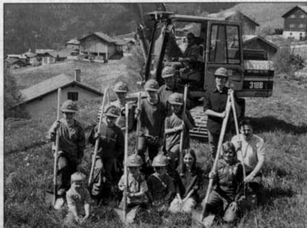
Tatkräftig unterstützt durch Kinder aus Mathon konnte der Spatenstich für die Tgea Muntsulej vorgenommen werden.
